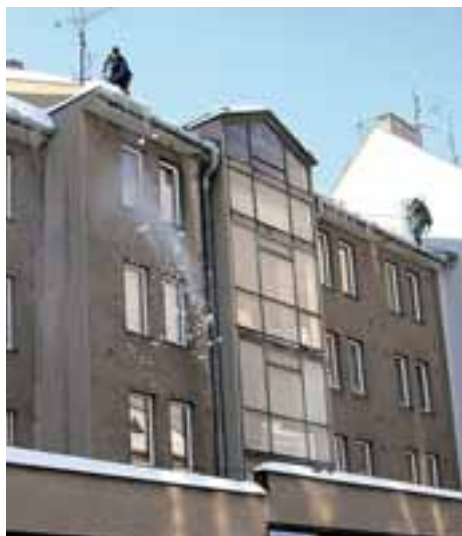
Sníh na střechách a komunikacích - věčný problém zimního období
